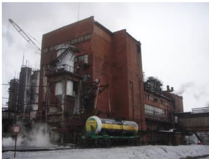
Рис.3. Внешний вид здания до аварии
