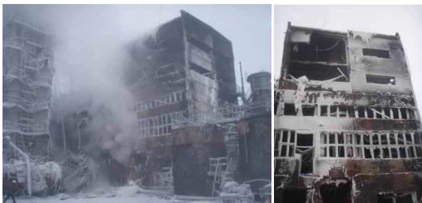
Рис. 4. Внешний вид здания в первые сутки после аварии
