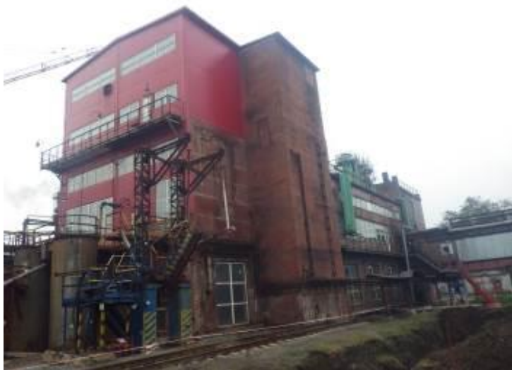
Рис. 7. Внешний вид здания после восстановления строительных конструкций
