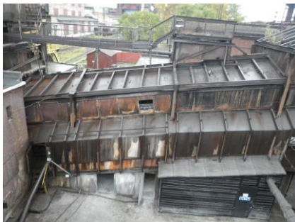
Рис.2. Общий вид наклонной галереи РМ-1
