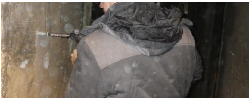
Рис. 4. Подготовка бетонной поверхности к установке прибора «ПИБ»
