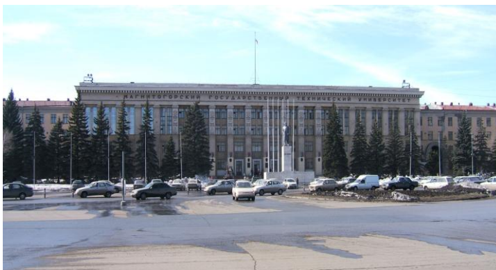
Рис.1. Здание ФГБОУ ВПО «МГТУ им. Г.И.Носова», в котором размещается АСФ
