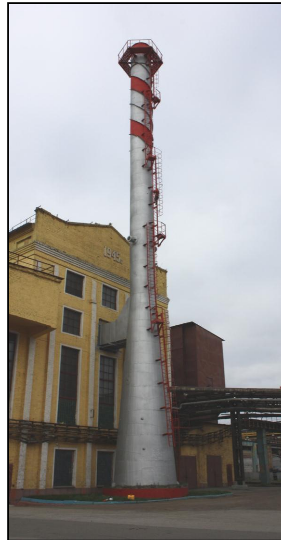
Фото 1.3 Свободностоящая металлическая труба с верхней цилиндрической частью и нижней – конической (рис. 1.1, в)
