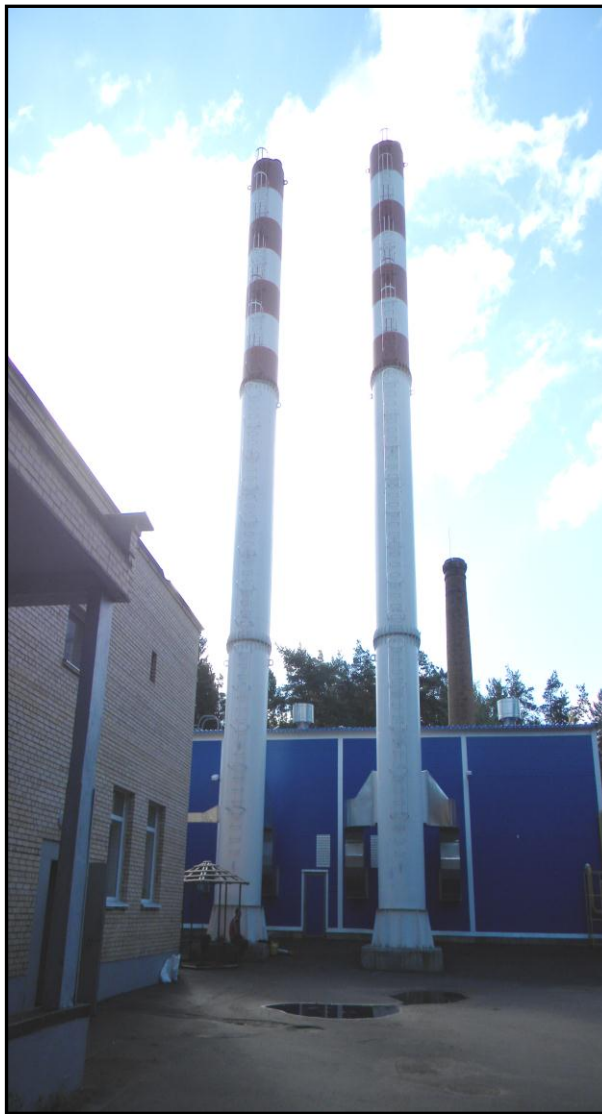
Фото 1.2. Цилиндрическая металлическая труба (рис. 1.1, б)
