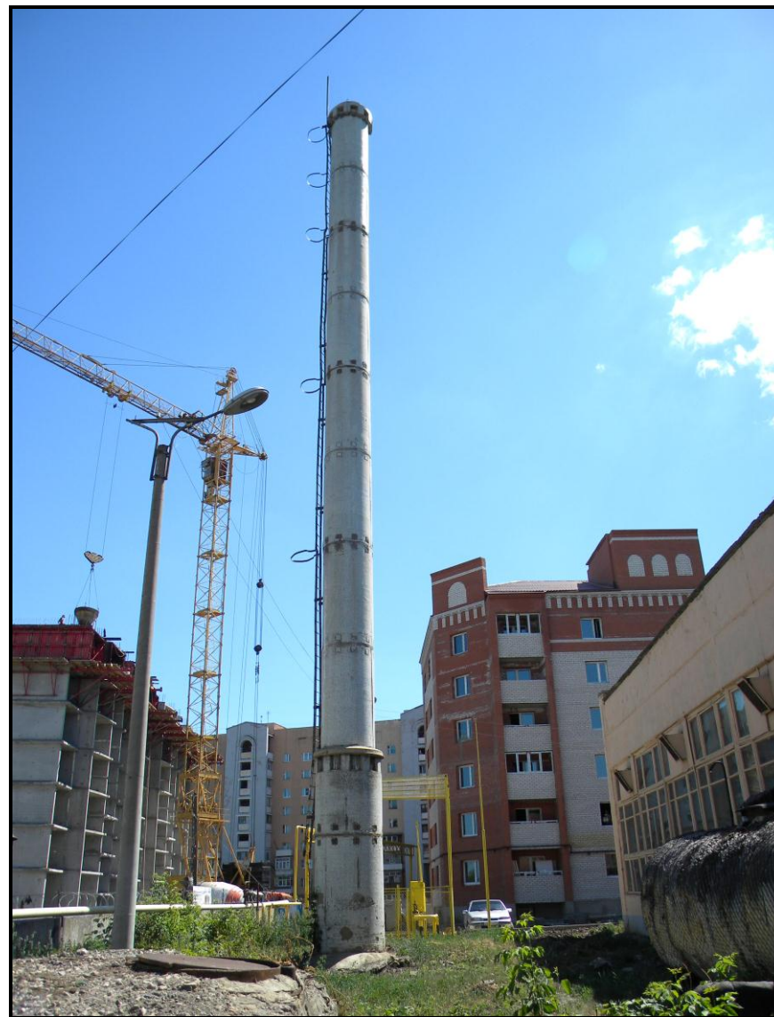
Фото 3.2. Цилиндрический железобетонный газоотводящий ствол (рис. 3.1, б)
