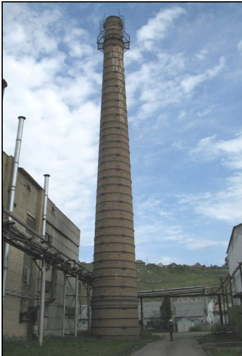
Фото 2.1. Коническая газоотводящая кирпичная труба (рис. 2.1, а)
