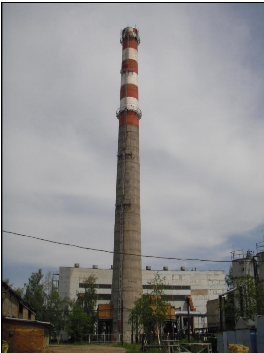
Фото 3.1. Конический железобетонный газоотводящий ствол (рис. 3.1, а)
