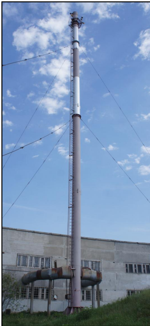
Фото 1.1. Цилиндрическая металлическая труба на вантовых оттяжках (рис. 1.1, а)
