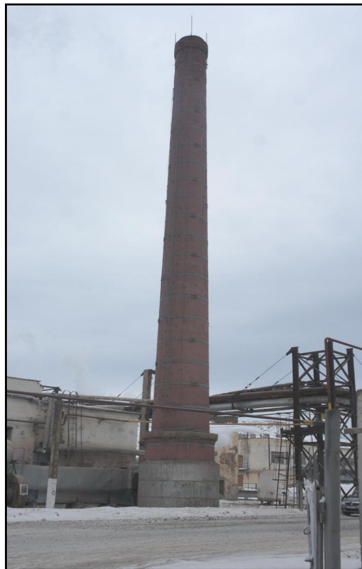
Фото 2.2. Кирпичная газоотводящая труба с верхней конической частью и нижней – цилиндрической (рис. 2.1, б)
