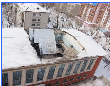
Рис. 3. Обрушение крыши СК «Спартак», г.Благовещенск
