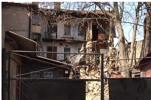
Рис. 7. Обрушение трехэтажного жилого дома в г.Одесса
