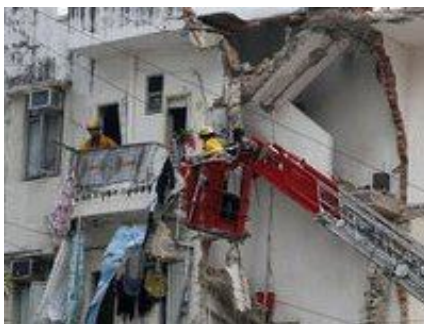
Рис. 4. Обрушение жилого здания в Гонконге
