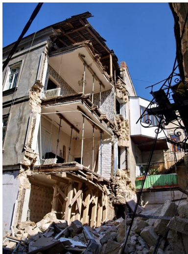
Рис. 8. Частичное обрушение столетнего жилого дома в г.Одесса
