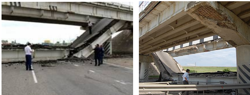
Рис. 18. Обрушение части моста на федеральной трассе М4
