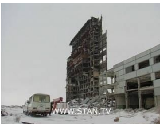
Рис. 14. Обрушение конструкций здания на радиолокационной станции "Дарьял-У"
