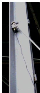
Рис. 3. Направление сканирования и расположение сканирующих устройств при контроле несущих элементов узлов МК горы приземления трамплина (несущий пояс)
