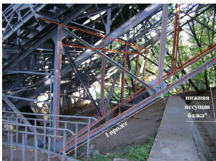
Рис. 2. Участки контроля и расположение несущих элементов узлов МК горы приземления трамплина
