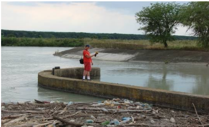
Рис. 7. Тепловизионный контроль бетонных плит крепления откосов
