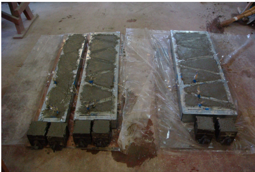
Рис. 6. Изготовление легких сталежелезобетонных конструкций
