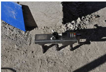
Рис. 4. Определение прочности бетона методом отрыва со скалыванием прибором «ОНИКС-ОС»
