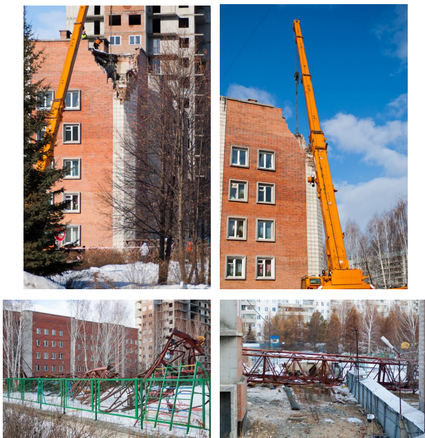
Рис. 5. Падение строительного крана на жилой дом, г.Якутск
