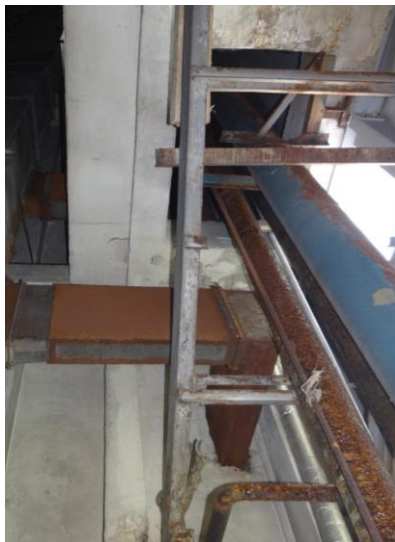
Рис. 3. Вертикальные связи между колоннами крайнего ряда
