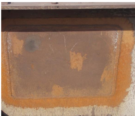
Фото 1. Удовлетворительное качество ремонта
