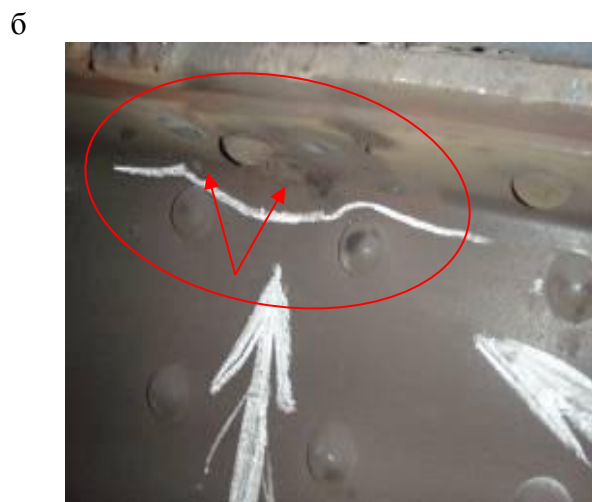
Рис. 1.21. Трещины в уголках верхнего пояса: а – продольные; б – поперечные
