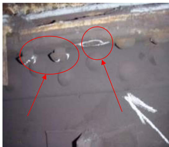
Рис. 1.22. Отсутствие, разрушение и ослабление заклепок верхнего пояса
