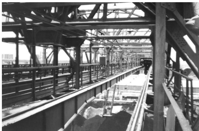
Рис. 1.5. Ездовые балки двутаврового сечения мостового перегружателя №2 коксохимического производства (КХП ОАО «ММК»)
