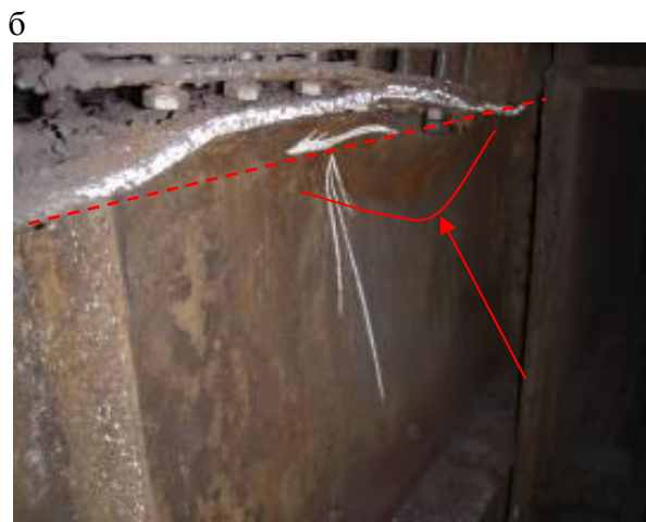
Рис. 1.23. Местные погибы элементов подкрановых балок: а – верхних поясов; б – стенок
