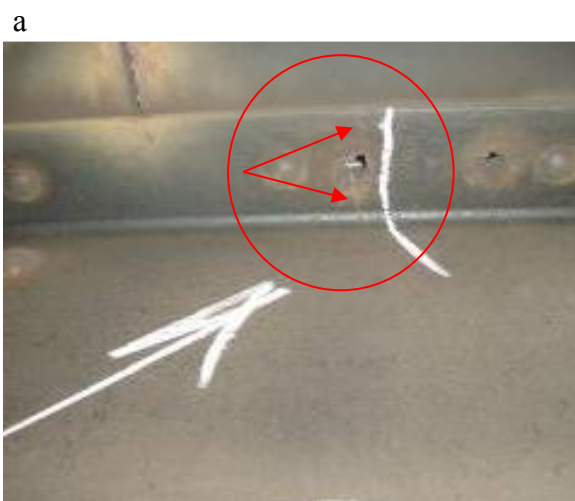
Рис. 1.21. Трещины в уголках верхнего пояса: а – продольные; б – поперечные
