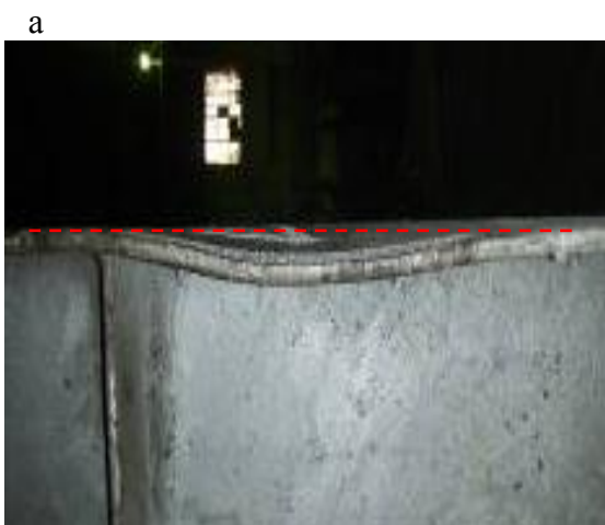
Рис. 1.23. Местные погибы элементов подкрановых балок: а – верхних поясов; б – стенок
