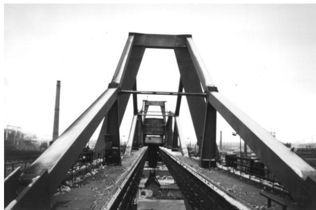
Рис. 1.6. Ездовые балки коробчатого сечения мостового перегружателя №6 КХП ОАО «ММК»
