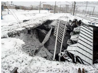
Рис.2. Провал, образовавшийся под действующей железной дорогой, расположенной над горными выработками в г. Березники Пермского края
