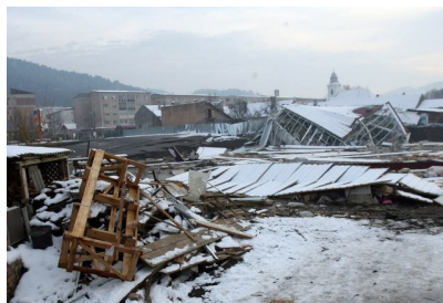
Рис.3. Обрушения земной поверхности в зоне влияния оработанной соленой шахты в Румынии
