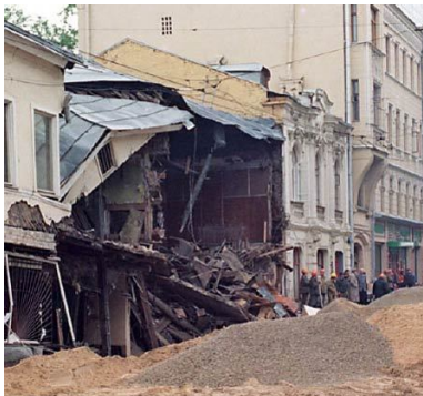
Рис.6. Провал, образовавшийся на улице Большая Дмитровка, г. Москва
