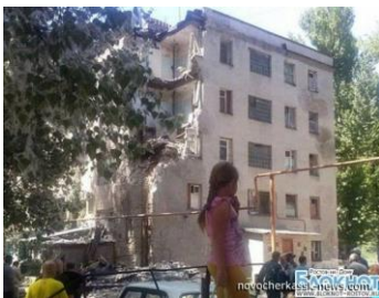
Обрушение перекрытий и стен в туалетах пятиэтажного здания 29.05.2013 г. в г.Новочеркасск, Ростовская область
