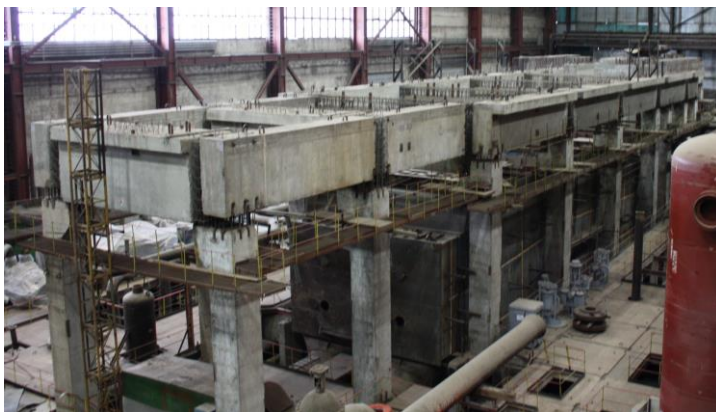
Рис. 2. Общий вид фундамента
