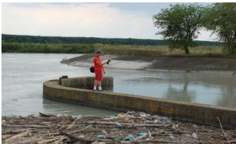
Рис. 7. Тепловизионный контроль бетонных плит крепления откосов
