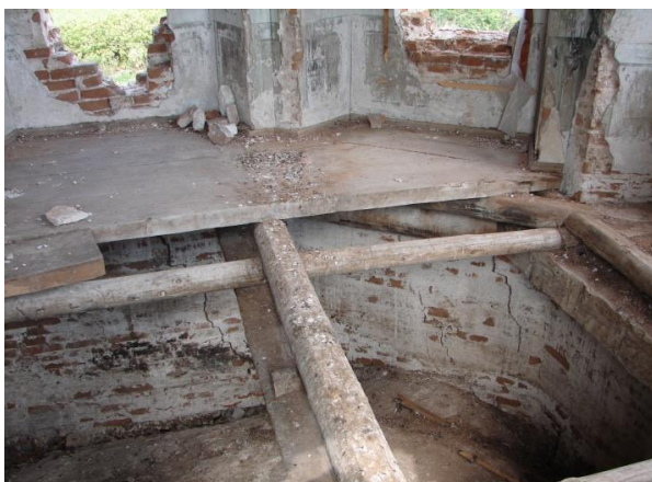
Рис. 3. Трещины в стене алтаря
