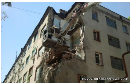
Обрушение перекрытий и стен в туалетах пятиэтажного здания 29.05.2013 г. в г.Новочеркасск, Ростовская область
