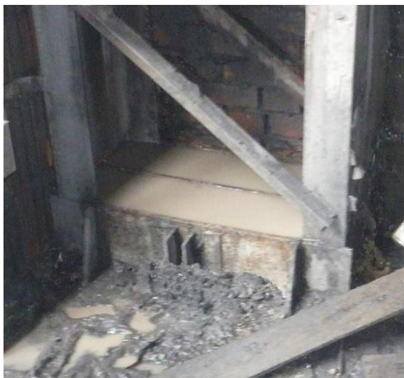
Рис. 4. Застой воды в нижнем опорном узле колонны вследствие забивания сливного отверстия в трассе базы
