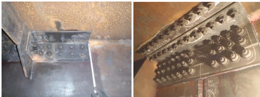
Рис. 1. Фото усиления зоны сопряжения стенки с верхней полкой нижнего пояса подкраново-подстропильной фермы в ККЦ ОНПС ОАО «ММК»
