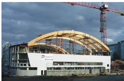
Рис. 2. Монтаж клеедеревянных арок пролетом 48 м на этапе строительства первого здания
