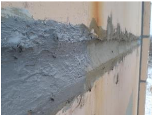
Рис. 5. Герметизирующая мастика поверх существующего слоя герметика
