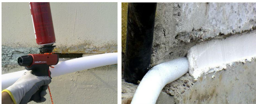
Рис. 6. Вторичная герметизация межпанельных швов со вскрытием стыков
