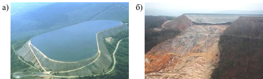
Рис. 1. Верховой бассейн ГАЭС Таум Саук (США) до (а) и после аварии (б) в 2005 г.
